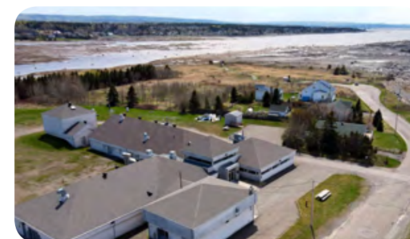
Station aquicole à Rimouski qui abrite le laboratoire sur l'impact des changements globaux sur les organismes de l'estuaire du Saint-Laurent. © ISMER-UQAR
